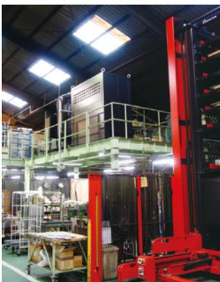
工場スペースが一杯なので中2階へ上げられた窒素ガス発生装置 PSA-10002HT
